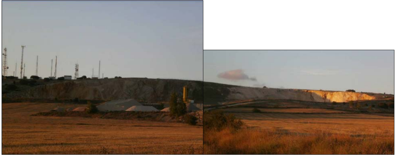
Figura 11. Vista actual de la cantera "Rubena" desde el trazado alternativo del Camino de Santiago a su paso por Cardenuela Riopico.
